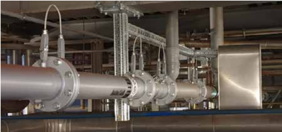
Überwachte Rohrteile DN125 – PN10
