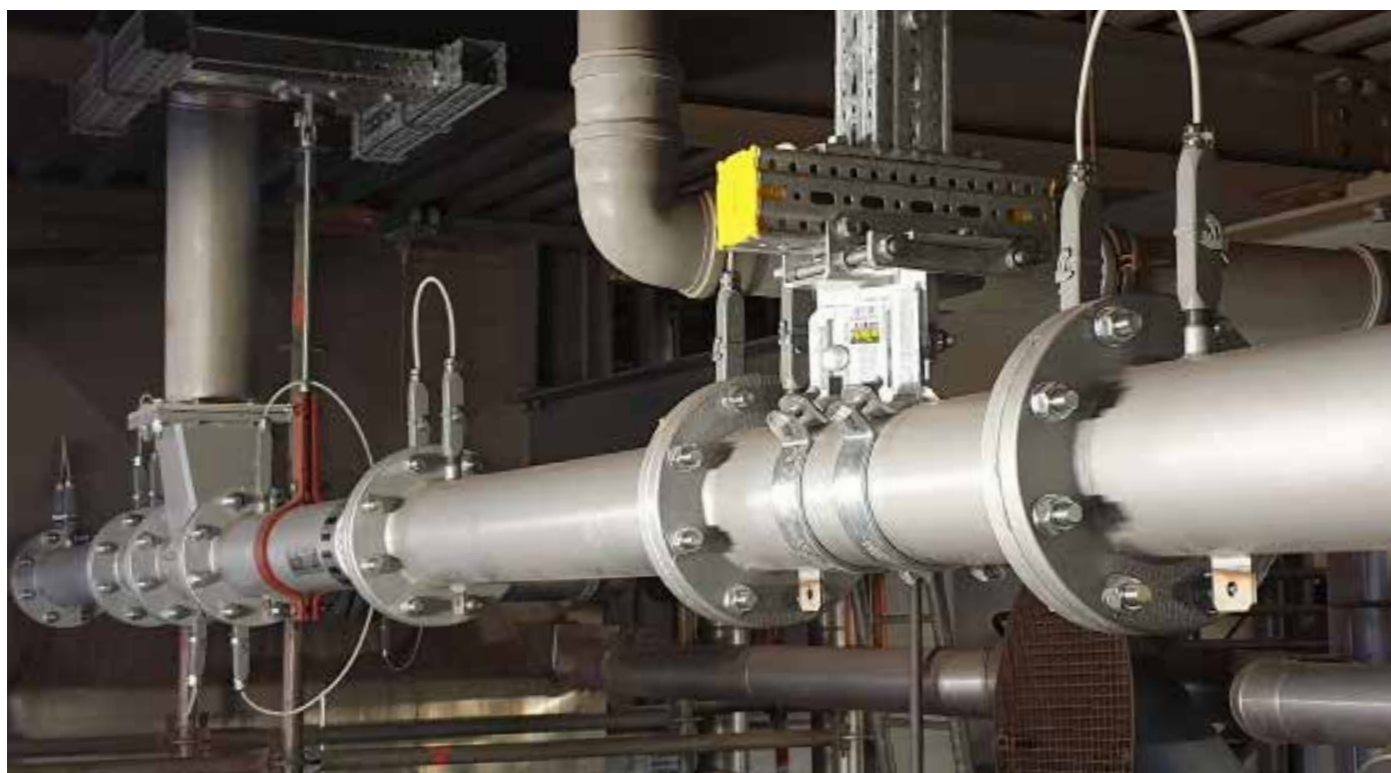
Überwachte Ascheleitung, Innendurchmesser 80 mm
