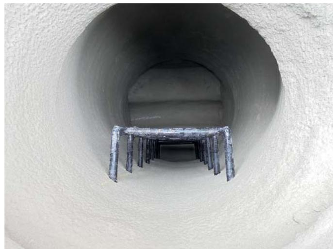
Mittels Schleudertechnik beschichteter Schacht
